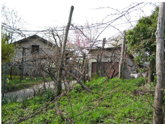
Hiša 1 pred rušitvijo
