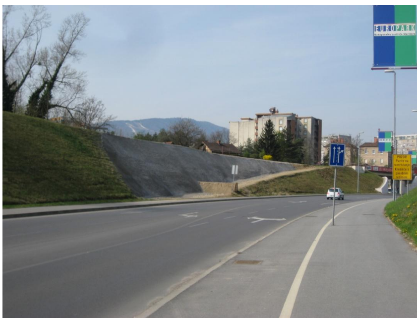
Stanje po sanaciji brežine
