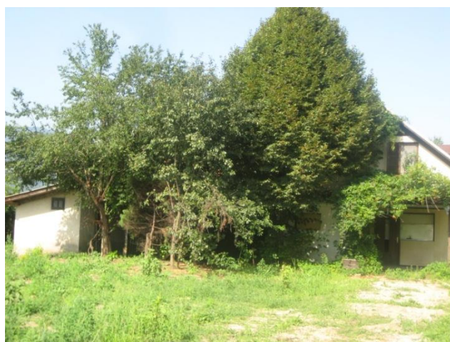
Hiša 2 pred rušitvijo
